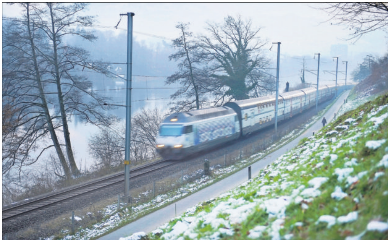
Bei dieser Zugstrecke entlang des Rotsees könnten dereinst Züge auf der Strecke Luzern-Zürich im Viertelstundentakt verkehren.
